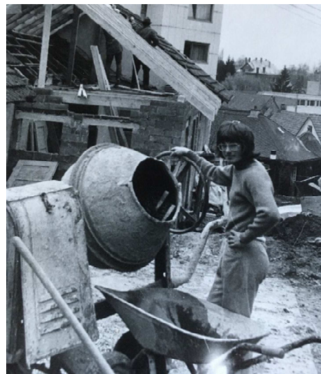
Baustelle Kegelbahn auf dem Kirchberg im Sommer 1972
